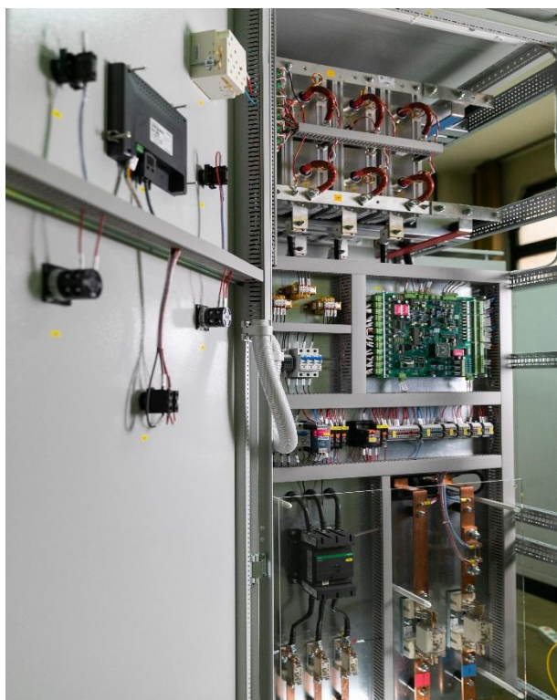
Слика 7. Изглед исправљача – предња страна
