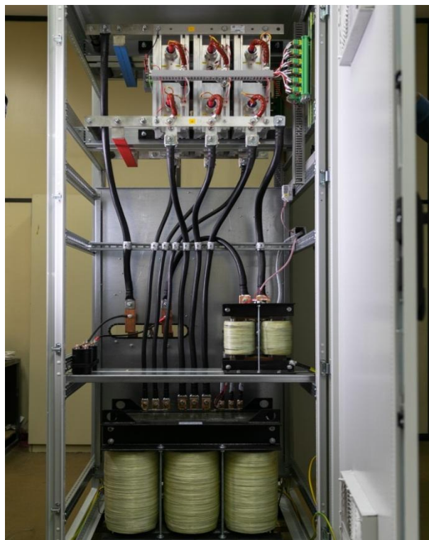
Слика 8. Изглед исправљача – задња страна
